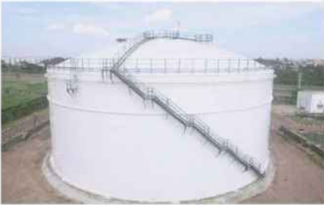
Avtur Tank 17.000 KL - Banten
